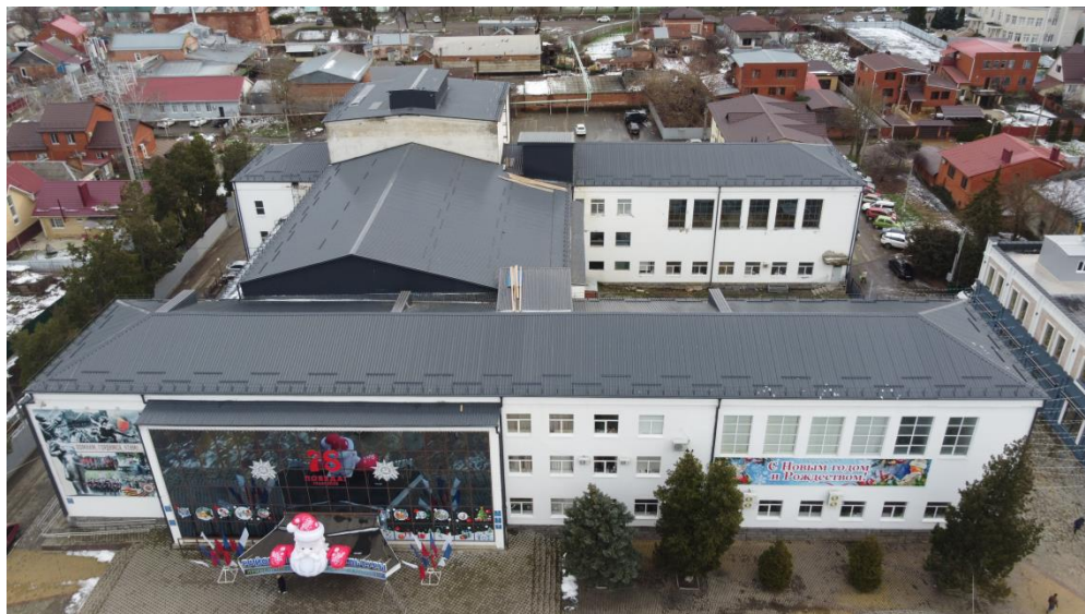
Капитальный ремонт кровли здания МБУК МО Кореновский район «Кореновский районный центр народной культуры и досуга»
